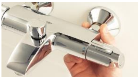
Rozetten controleren
