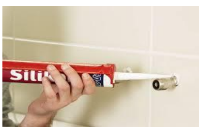
Nieuw kitwerk aanbrengen achter rozetten
